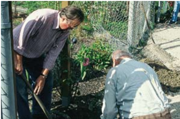
Gemeinschaftsarbeit zur Verlegung von Wasserrohren: Josef Ginglseder und Georg Nowotni
