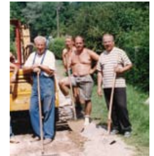
Gemeinschaftsarbeit für das Wasserrohr
